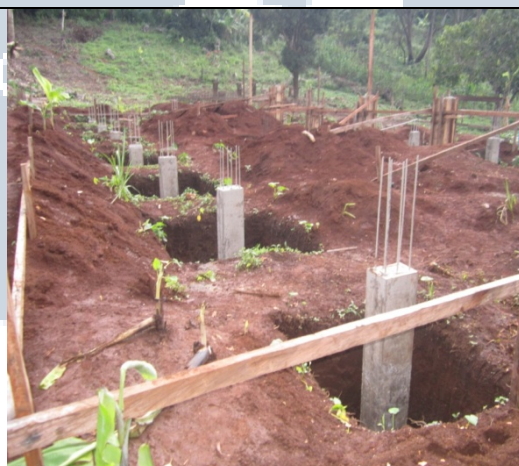
Une vue de la façade principale après le coulage des semelles et amorces
