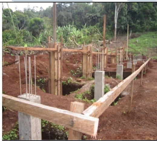
Une vue de la façade principale après le coulage des semelles et amorces
