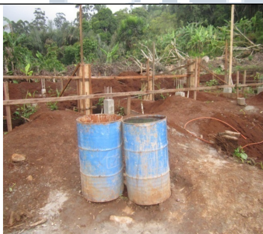
Une vue d'ensemble après le coulage des semelles et amorces
