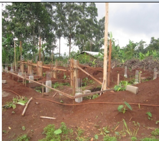
Une vue d'ensemble après le coulage des semelles et amorces
