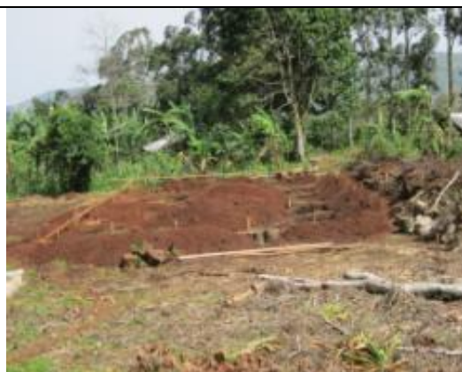
Une vue d'ensemble de la fondation après les fouilles
